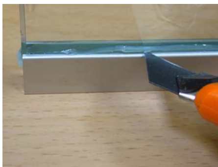
Überschüssiger Kleber wird mit einem Messer entfernt.
